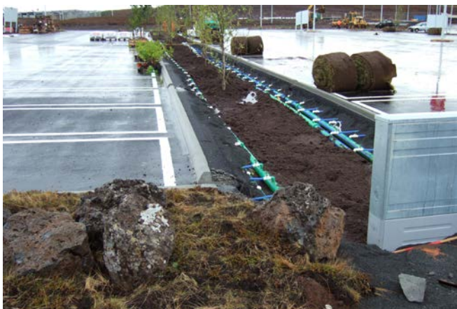
Mynd 15 Blágrænar ofanvatnslausnir í Kaupþúni, Garðabæ, á framkvæmdartíma.
